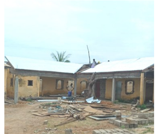
È stata aperta una finestra a fianco di ogni porta, rifatto e alzato il tetto e aggiunto un piccolo portico per riparare dalla pioggia.
