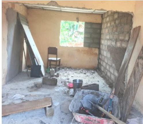
Dove possibile, sono state eliminate, o spostate, delle pareti per avere camere più grandi.
