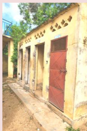
A sinistra i nuovi servizi igienici, con i due ingressi, per i ragazzi e le ragazze. All'interno lavandini, docce e wc.
